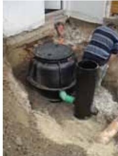
5.) Probenahmeschacht setzen
