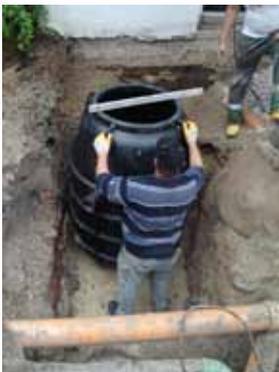
3.) Fettabscheider ausrichten
