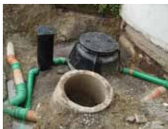
6.) Abwasserrohr wasserdicht anschließen
