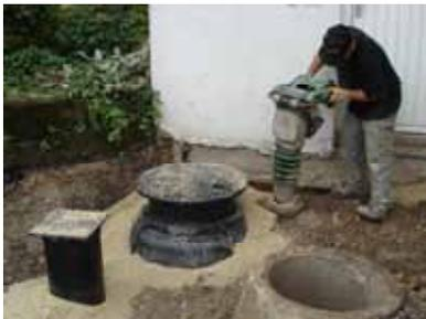
11.) ...Grube Verfüllen und Verdichten
