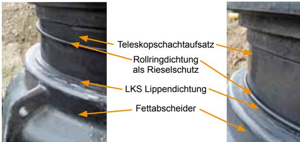
Teleskopschachtaufbau in Behälteröffnung einschieben
